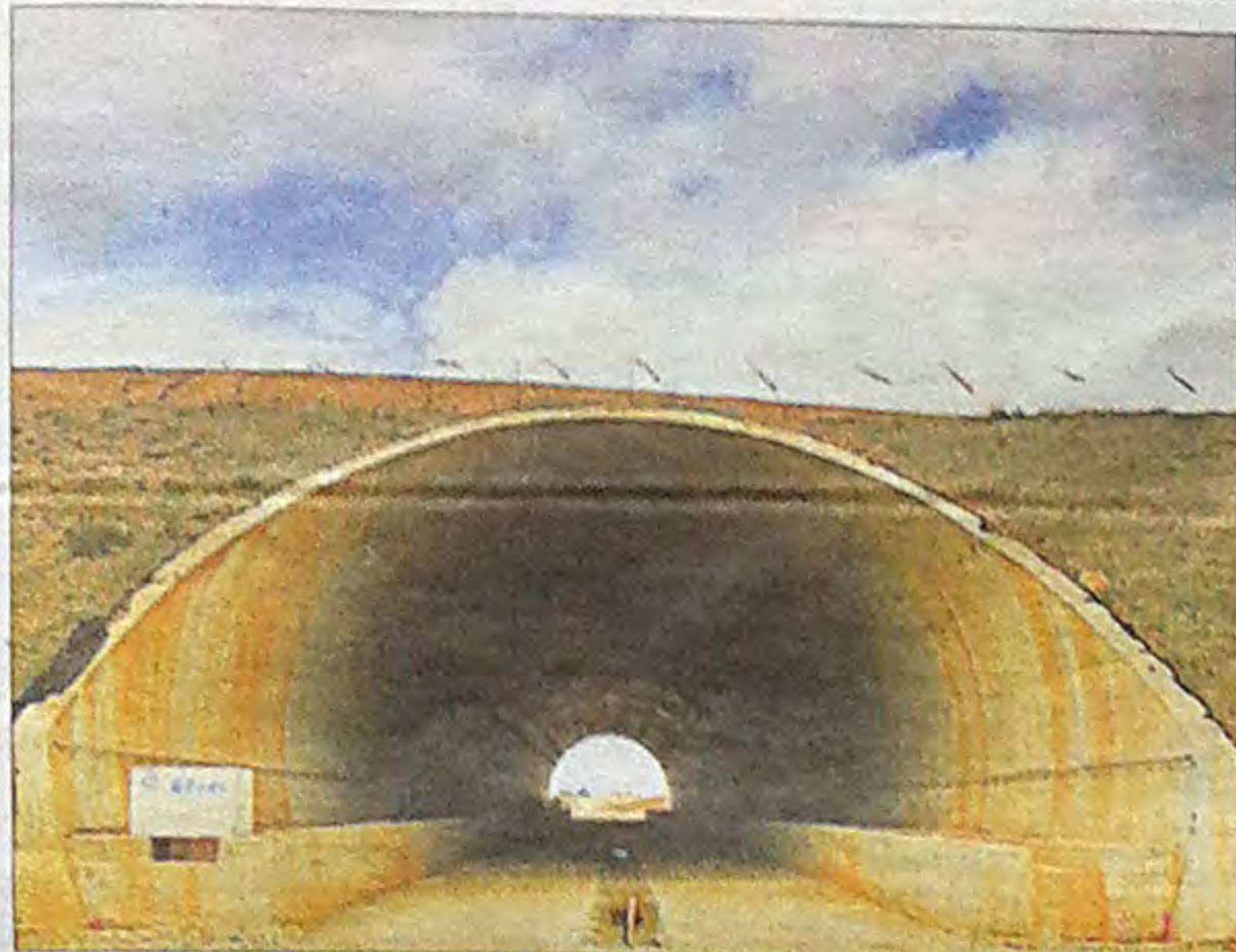
EL AVE, POR MOMBUEY. En el término municipal de Mombuey se sitúa este paso ecológico. | FOTO TREN ZAMORA
