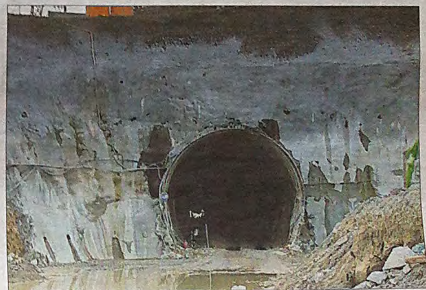
A TRAVÉS DE LUBIÁN. Este es el túnel que atraviesa el territorio de Lubián hacia Galicia, una distancia de unos pocos kilómetros. | FOTO TREN ZAMORA
