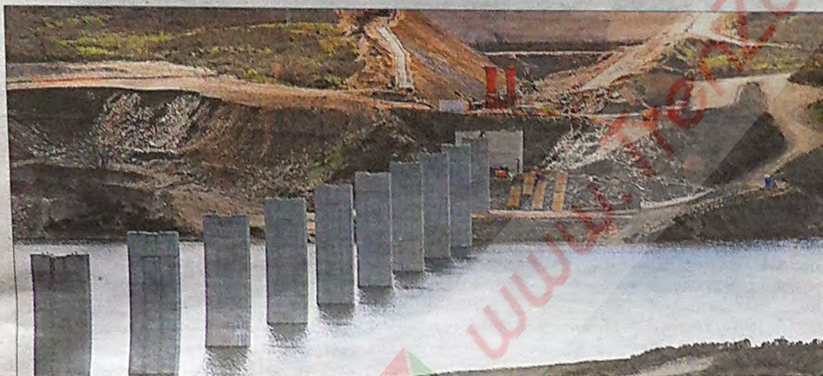
VIADUCTO SOBRE EL TERA. Una imagen reciente muestra la evolución de este viaducto sobre el Tera, un espectacular puente que permite dar continuidad al trazado hacia el norte del país. | FOTO TREN ZAMORA
