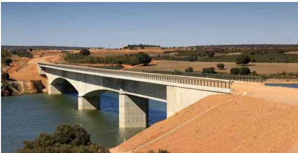
Puente sobre el embalse del Esla. Aunque tiene la fisonomía de un viaducto corriente, como el de una autovía, se trata del paso del AVE sobre el embalse del río Esla. La estructura cambia únicamente en la anchura, dado que el tren necesita menos espacio para circular. | Foto Tren Zamora | ZAMORA
