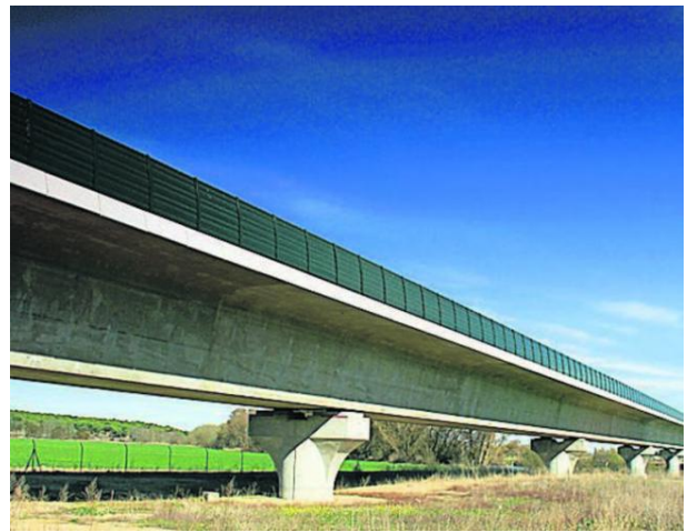
Estructura sobre el Duero. En la primera parte del trazado (Olmedo-Zamora) la mayor estructura se encuentra en Toro, sobre el río Duero. | Foto Tren Zamora | ZAMORA
