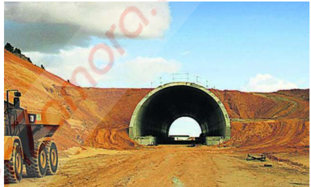
Paso ecológico de Tábara. Son túneles artificiales que respetan el paisaje y la fauna, como este situado en el término de Tábara. | Foto Tren Zamora | ZAMORA
